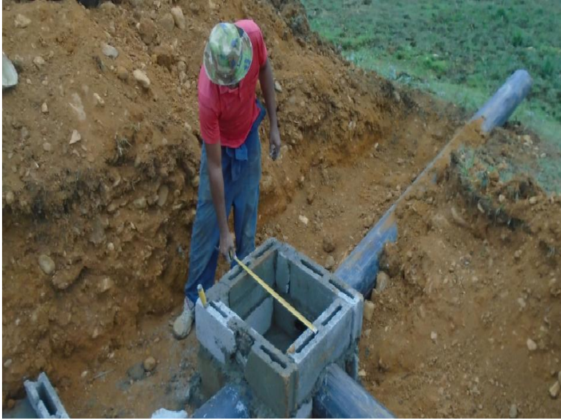
Figura 9. Construcción de registro de entrada múltiple. [Fuente el autora 2021].
