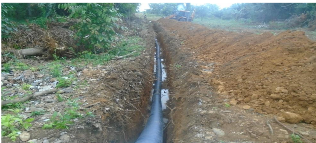
Figura 11. Instalación de conducto de salida. [Fuente el autor 2021].
