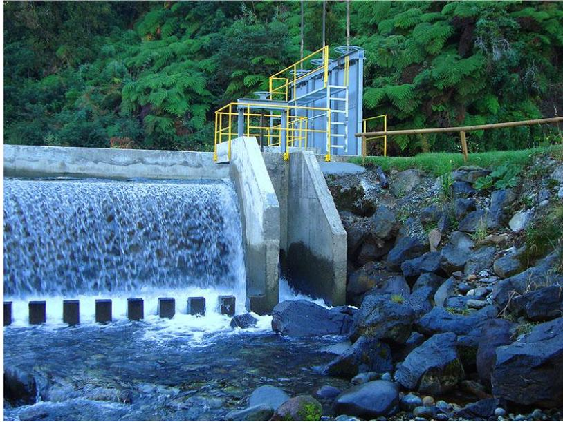
**Figura 2.11.** Imagen ejemplo de un dique de hormigón con aliviadero automático e instalación hidroenergética en canal lateral Imagen de un dique de cierre con aliviadero automático e instalación lateral de hidrogenación (arriba). Ejemplos de esquemas posibles a emplear con turbinas tipo Kaplan o Pelton (abajo).
