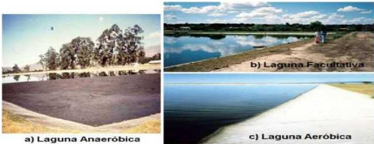
**Figura 1.7 Procesos mediante lagunas**
