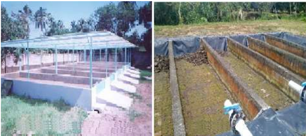
Figura 17. Lechos de secado de lodos (Fuente: https://images.app.goo.gl/KUT )
