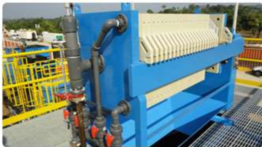
Figura 18. Filtros prensa para lodos (Fuente https://images.app.goo.gl/xDvSDxMq )
