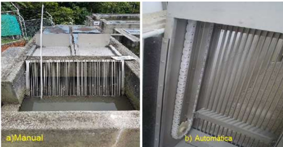
Figura 5. Cámara de rejas a) Manual, b) Automática (Fuente: https://images.app.goo.gl/BNxQ )
