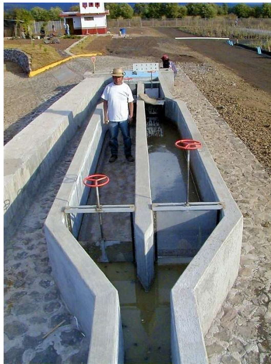
Figura 8. Desarenador (Fuente: https://images.app.goo.gl/fVhm9RER )
