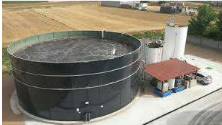
Figura 7. Tanque de homogenización (Fuente: https://images.app.goo.gl/3adFpEtUX )
