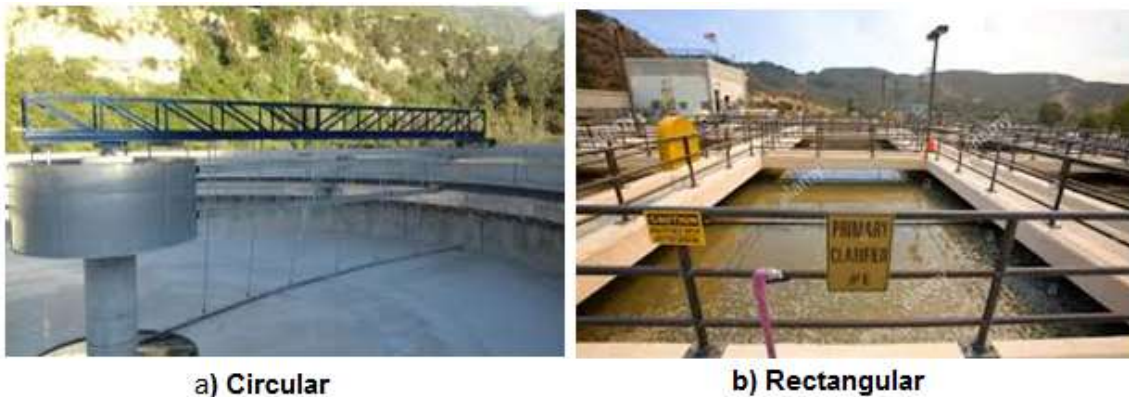
Figura 10. Decantadores (Fuente: https://images.app.goo.gl/gFyKyZZTD )
