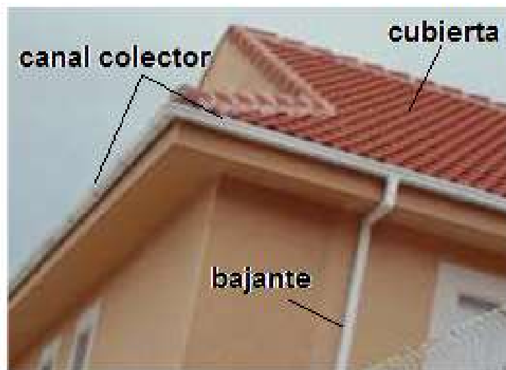
Figura 3.9. Componentes del sistema de drenaje pluvial (Fuente: URALITA, 2004)
