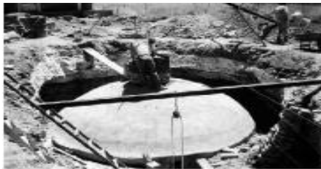
Figura.1.6. Biodigestor de cúpula fija en construcción
