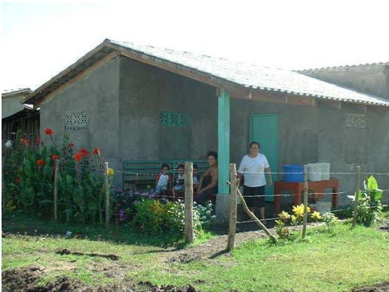
Foto: 14. Vivienda del Proyecto Malacatoya donde se utilizó la modalidad de autoconstrucción dirigida, el sistema de calicanto en las paredes (piedras de las montañas y arena de río), techos de tejas de microconcreto (TMC) producidas en el lugar. El sistema permitió la utilización de toda la fuerza de mano de obra de las familias beneficiadas (mano de obra no especializada), permitiendo construir viviendas de 54m<sup>2</sup> con costos muy bajos.<sup>27</sup>
