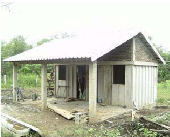
Foto: 13. El sistema constructivo de paneles de ferrocemento es de fácil aplicación, no requiere de mano de obra calificada, un núcleo se construye en 30 días laborables, por tanto es de colocación rápida lo que se traduce en bajos costos de ejecución.
