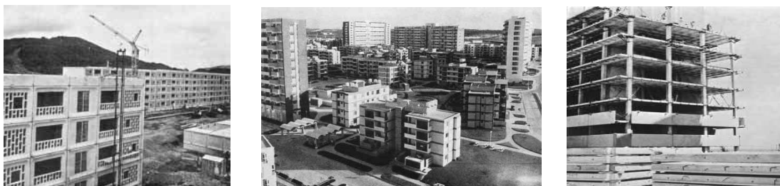
Las imágenes muestran construcciones típicas de la Revolución: de izquierda a derecha edificaciones Gran Panel Soviético, edificios de la urbanización de Habana del Este y construcción de un edificio IMS.
