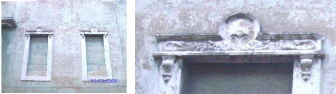
Fig. 1.19- Ubicación de elementos decorativos en la fachada a la calle F. Crombet. (Fotos tomada por el autor).
