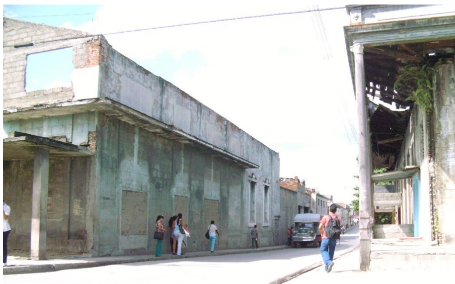
Fig. 1.23-Calle Flor Crombet. Al fondo punto de transportación de personal. (Foto tomada por el autor).
