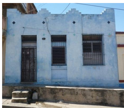
Acceso peatonal a desnivel. Presencia del pretorio
