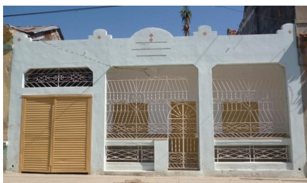
Acceso peatonal a nivel
