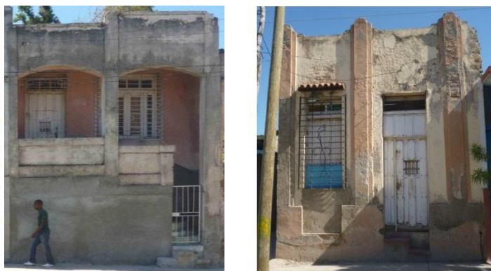
Vivienda con basamento por topografía
