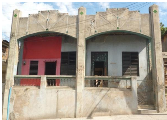
Corredor integrado a la fachada
