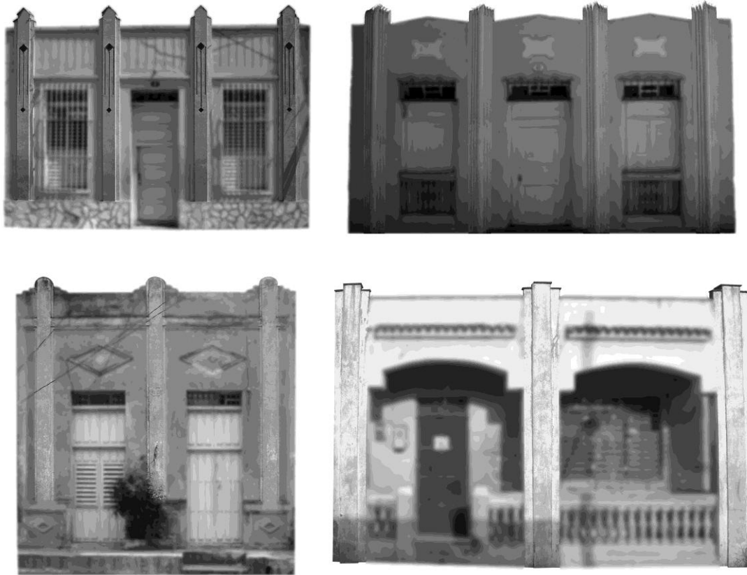
Figura 2.14- Tipos de pilastras que componen las fachadas Art Decó de los barrios obreros
