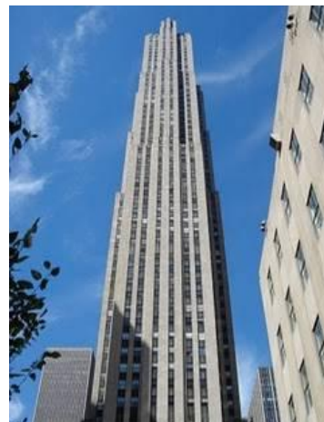
Edificio de la RCA Corporation, Nueva York, 1931. Cross & Cross
