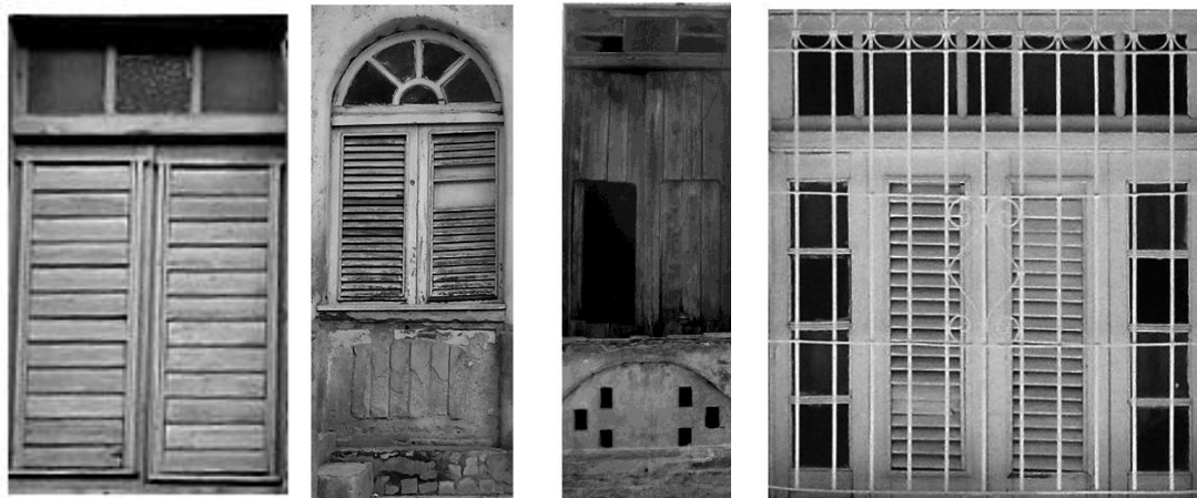
Figura 2.15- Tipos de carpintería empleados en las construcciones Art Decó de los barrios obreros
