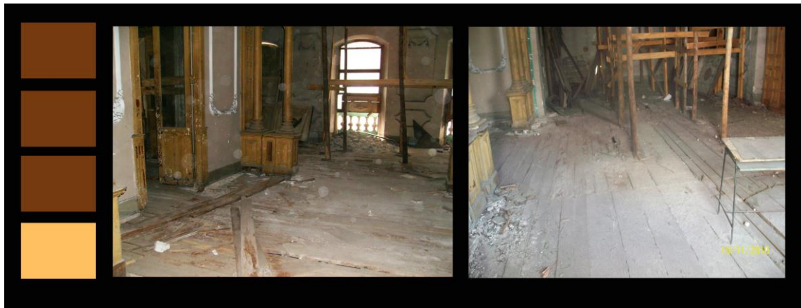
Fig.17 Ausencia de solución de piso en parte del 2do Nivel
