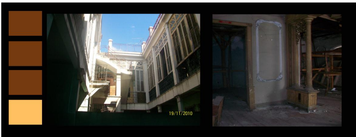
Fig.9 Patio interior, rodeado por las oficinas de Gobierno.
