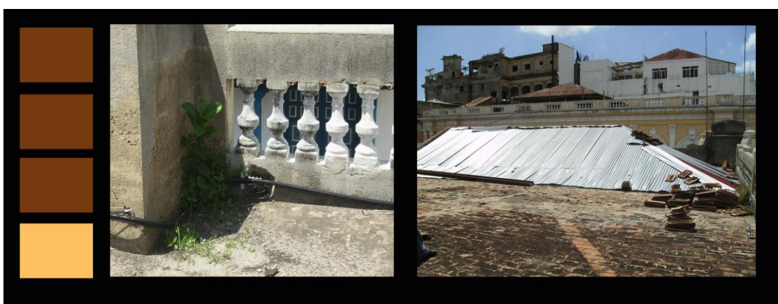
Fig.14 Solución de cubierta en la Primera crujía (Tejas de Zinc Grecadas)
