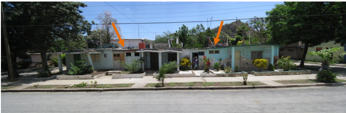
Foto 49. Viviendas construidas entre dos residencias.
