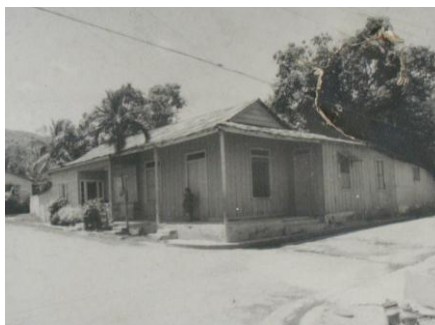
Foto 45. Vivienda N° 53. Instantánea realizada a finales de la década del '50.
