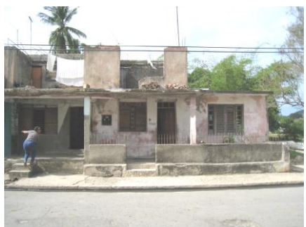
Foto 36. Vivienda N° 109, estado actual.
