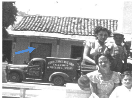
Foto 43. Vivienda N° 105 en tiempos de la neocolonia
