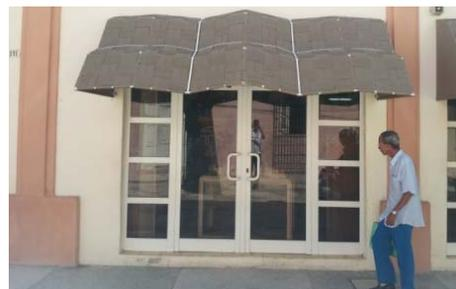
Fig. 2.22 Toldo de dimensiones funcionales y congruentes con el área del vano.
