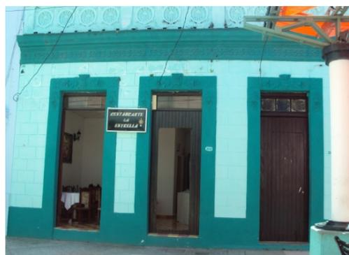
Fig. 2.24 Carpintería que mantiene el tamaño, la proporción y la distribución original.
