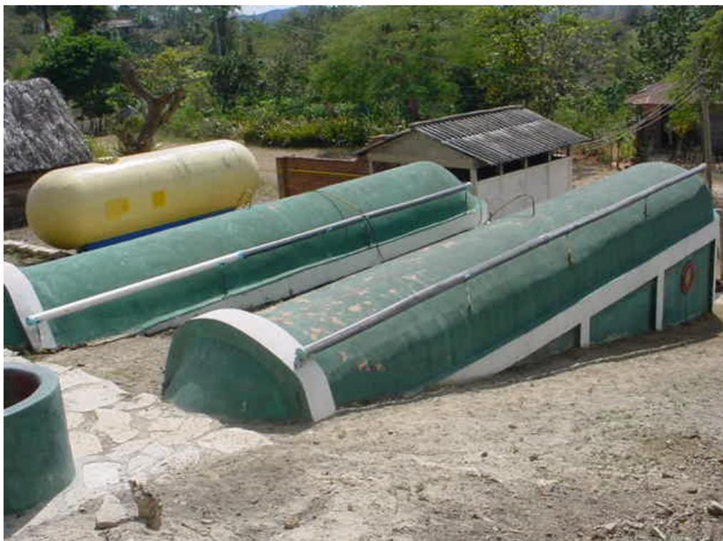
Figura 1.5 Foto de los digestores y el gasómetro de Magueyal.
