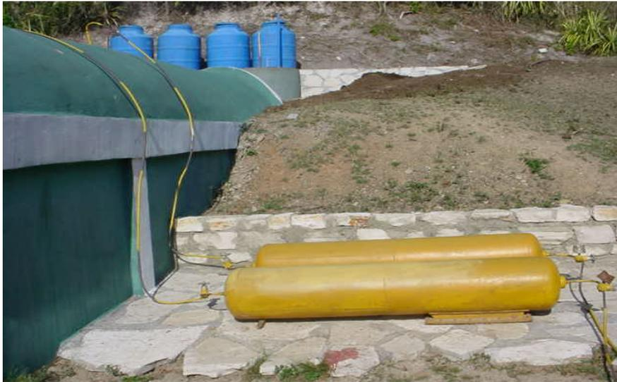
Figura 1.6. Filtros del biogás en la instalación de Magueyal.
