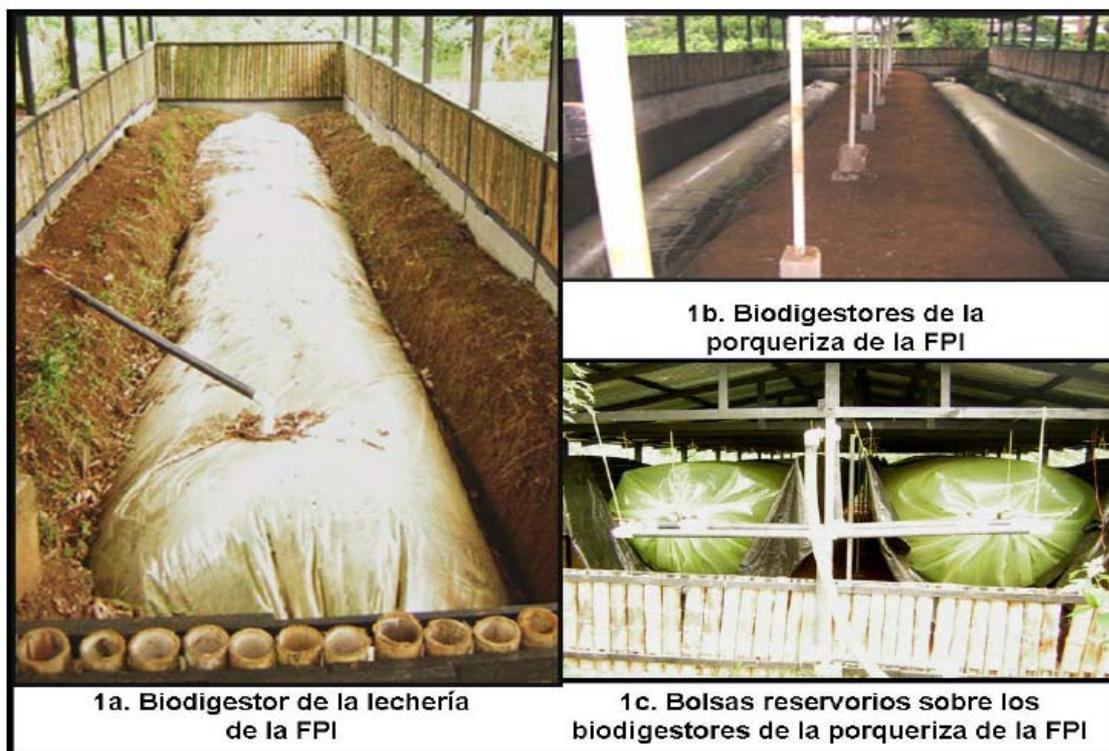
Figura 1.3. Reservorios para el almacenamiento del biogás.
