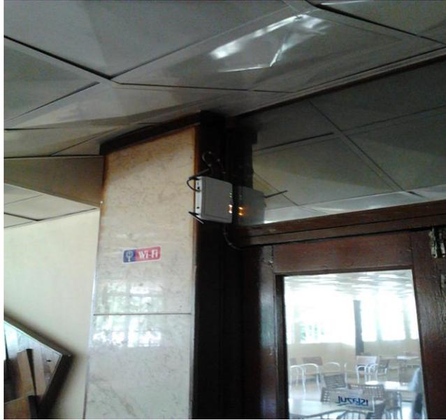
*Fig.VI.1* Ubicación del AP BW 1253 instalado en la cafetería.
