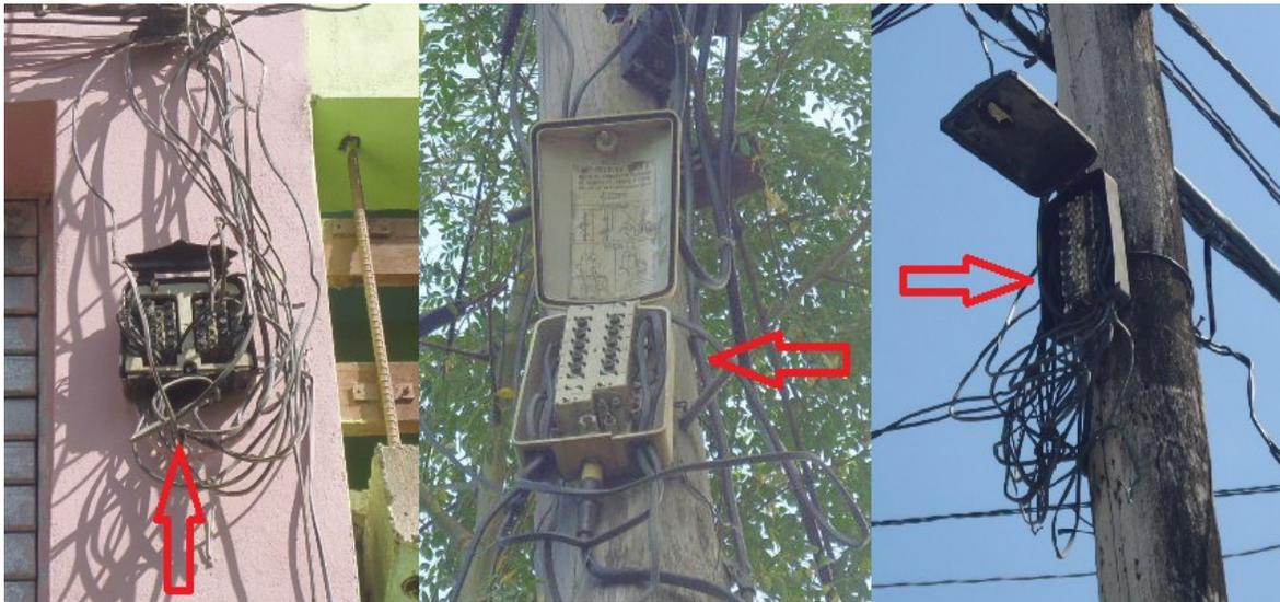
Figura 2.8. Ejemplo de cajas terminales que están dañadas, no tienen tapa y necesitan mantenimiento.
