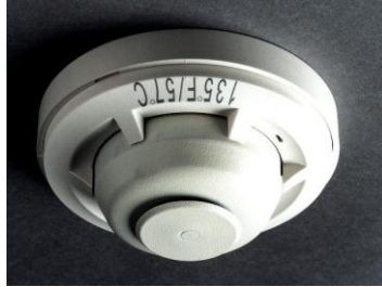
Fig.1.14. Detector de Temperatura. Tomado de [11].
