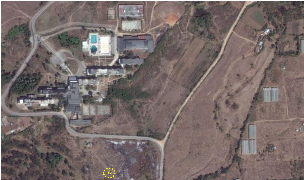
Figura 3.4. Vista satelital del transmisor de la EIDE. (Imagen tomada de Google Maps)
