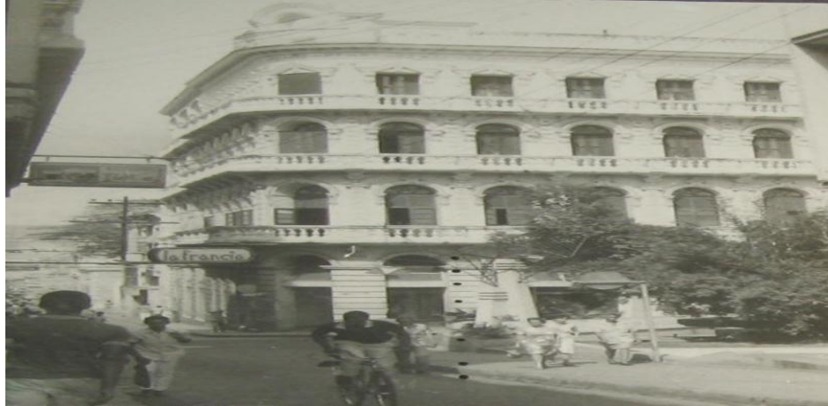
Figura 2.1. Hotel Imperial reconstruido después del terremoto de 1932
