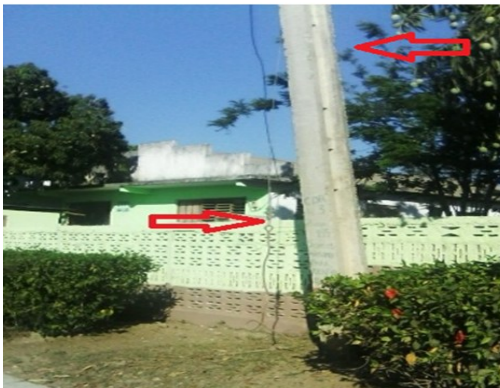
Figura 2.5. Ejemplo de postes que están con riostras sueltas e inclinados.
