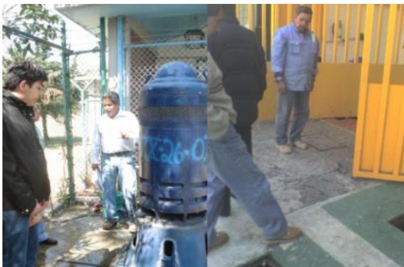
Figura 1.4. Visitas de campo realizadas a los puntos de instalación de los medidores electromagnéticos. Fuente: Ochoa, (2020).
