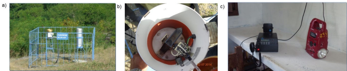
Fig. 8b. Equipos utilizados en el en la Potabilizadora Guaso.
