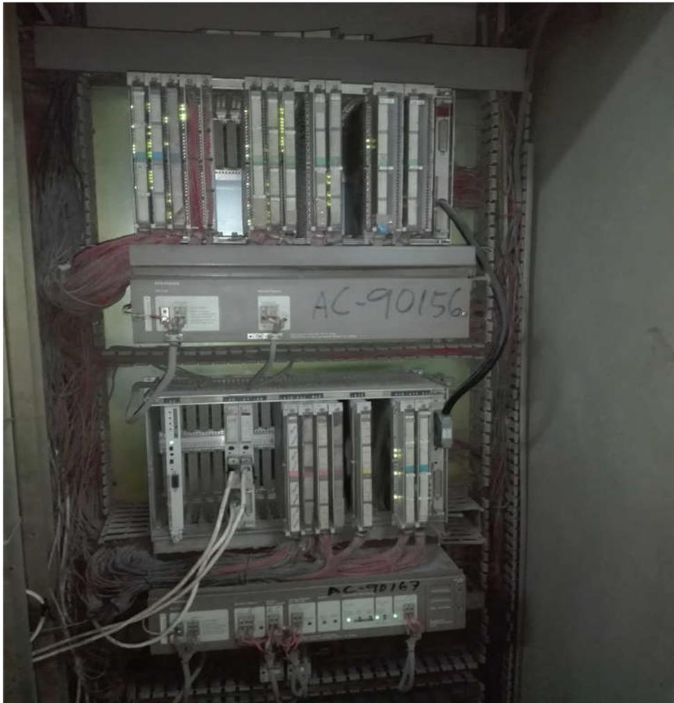
*Figura 1.15. Plc Simatic S5 135u De La Siemens Para El Control De Flujo De Gas En El Horno Cuchara.*
