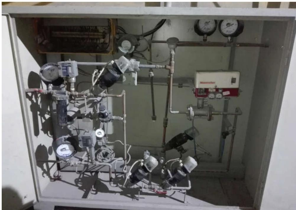
Figura 1.11. Rampa Distribuidora Del Gas (Argón O Nitrógeno)
