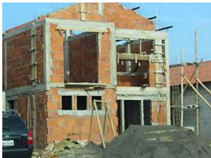
**Figura 1.2.** Imagen de la construcción de una vivienda de dos plantas con un sistema constructivo tradicional de vigas y columnas. Fuente: Cedeño, 2015.
