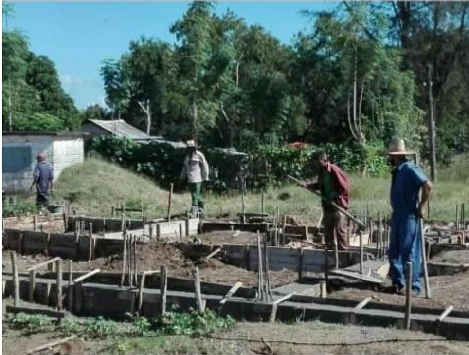
**Imagen 2. Ejecución de la construcción de los cimientos de la casa de explotación de la presa Paso Malo**
