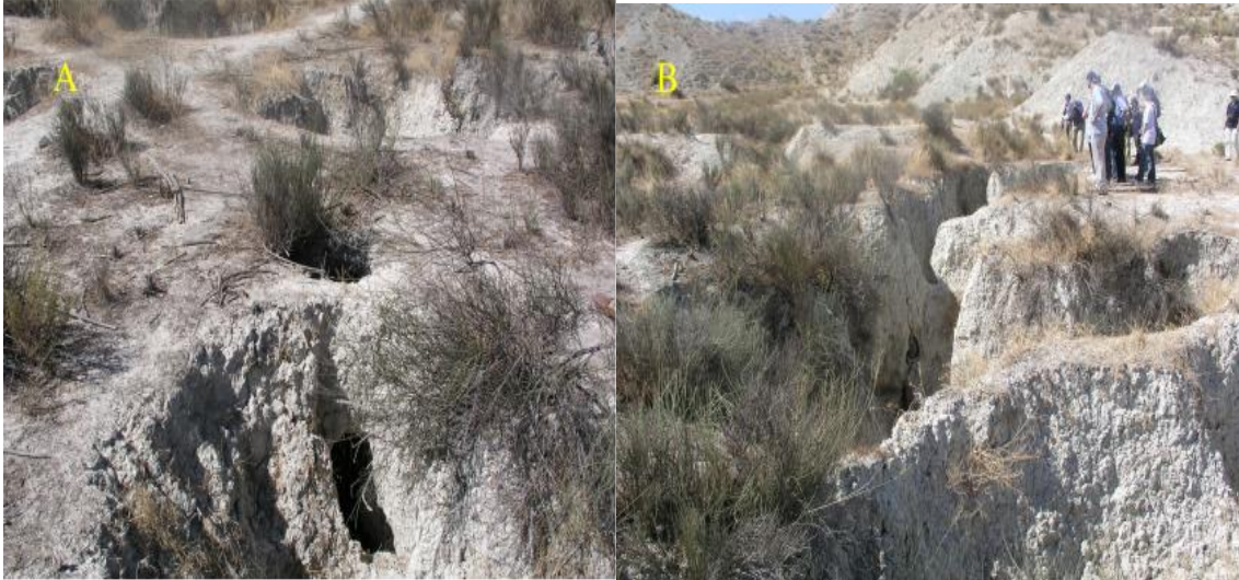
Foto 5: (A) Pozos formados por derrumbes parciales y (B) derrumbe generalizado de la galería. Mula (Murcia, España). (Foto: P. García-Estríngana)
