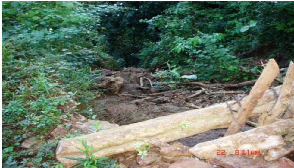
Foto 11. Dique de ramas para evitar el avance de las cárcavas (diciembre 2005).
