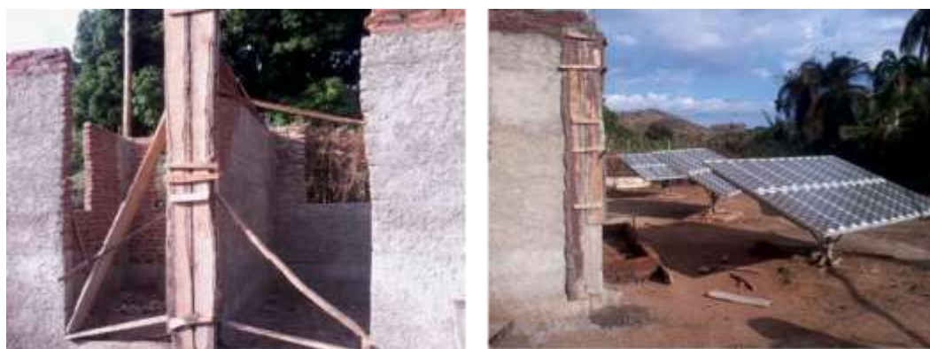
Figura 1.7 Imágenes de las casetas de bombeo y el sistema fotovoltaico, en la actualidad existente en la comunidad La Magdalena.
