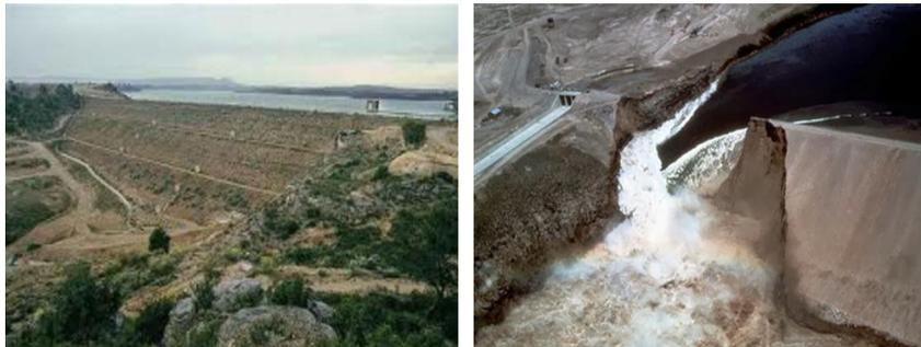
**Figura: 1.9** Vista de la presa de Caspe USA (izquierda) ([www.seprem.es](http://www.seprem.es)). Vista de la presa de Teton en (USA), la cual fallo por tubificación (erosión interna) en la cortina tras impacto de terremoto en 1967 (derecha): ([www.rinconabstracto.com](http://www.rinconabstracto.com)).
