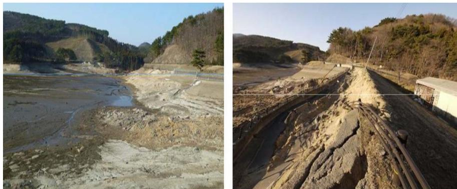
**Figura. 1.10** Vistas del deslizamiento del talud aguas arriba en la Presa de Fujinuma por efecto de un sismo, Tohoku el 12 de marzo de 2011. Fujinuma – Ike, colapsando el terraplén de cierre. (Carmona, Juan S., 2011).
