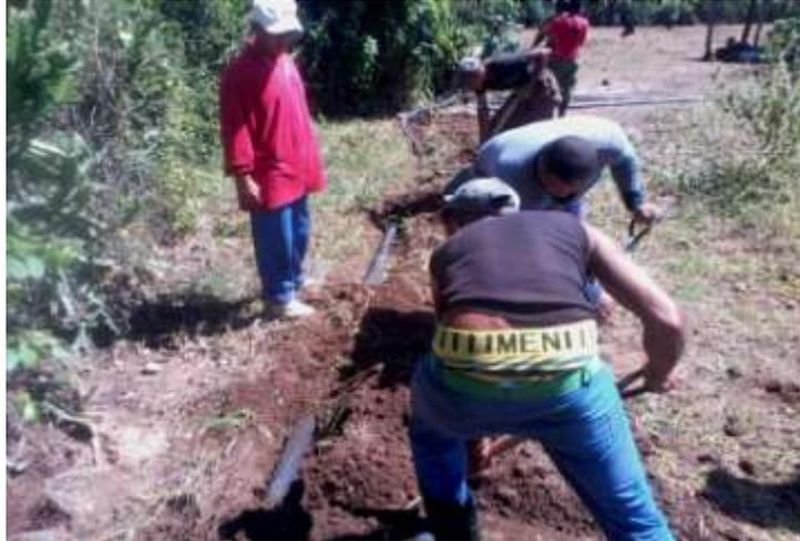
**Figura 6.** Imagen de la instalación de la tubería desde la cooperativa hasta el poblado en 2017.
