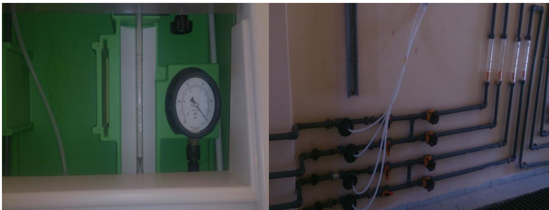
Figura 15. Dosificadores de cloro.
