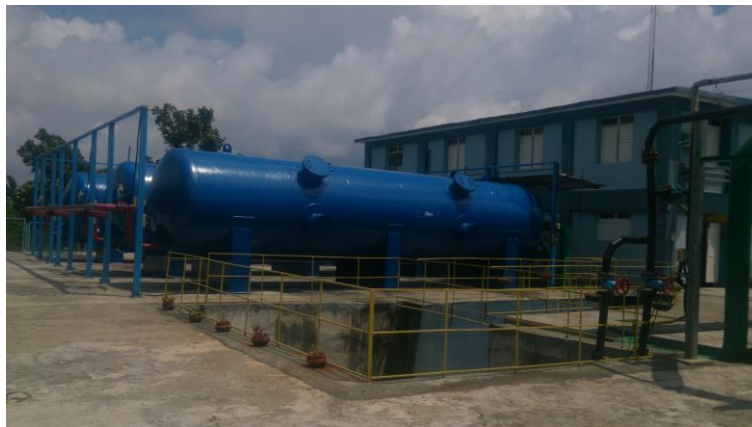
Figura 12. Filtros a presión.
