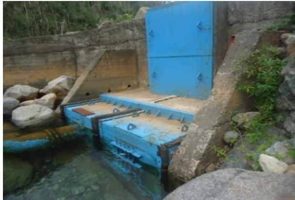
Figura 4 .Obra de toma.
