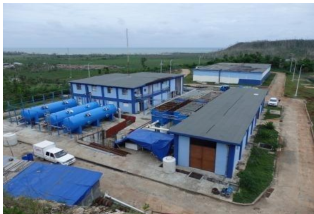
Figura 3. Planta Potabilizadora “Aguas del Duaba”
