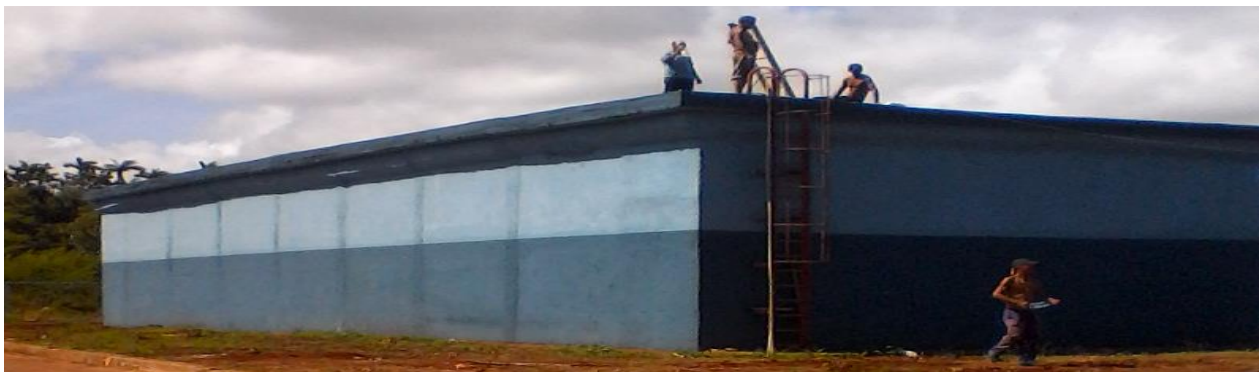
Figura 13. Tanque de agua tratada.
