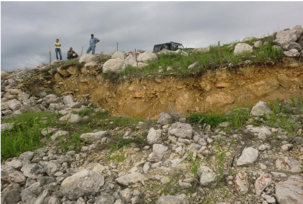
Foto 1. Deslizamiento de talud en Presa cauto del Paso. (Fuente GEARH)
