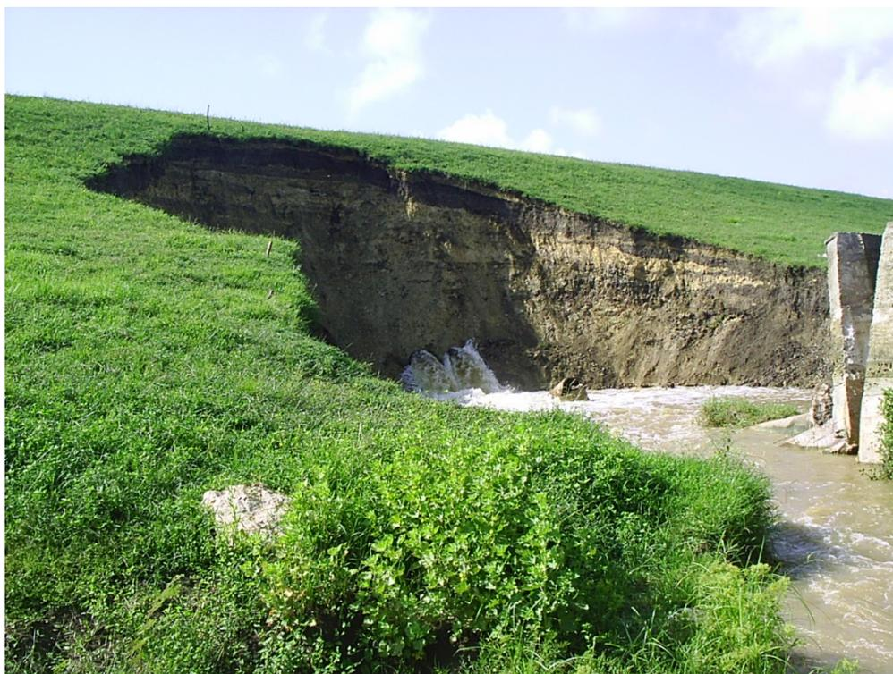
Foto 2 Deslizamiento clásico de talud seco por sifonamiento. Fuente (GEARH)
