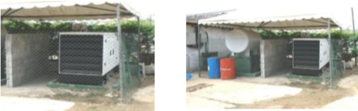
Fig. 1.7 b. Cercado perimetral.
