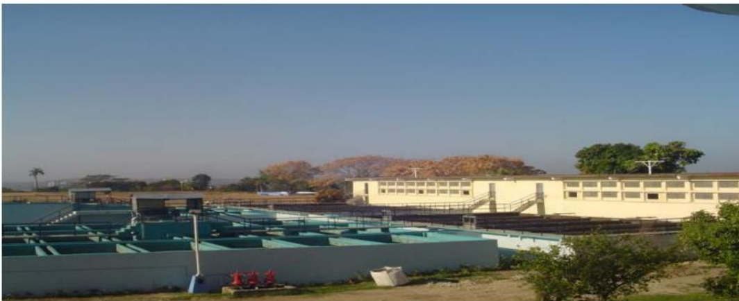
Fig. # 2.2 c. Planta potabilizadora “Quintero II”.
