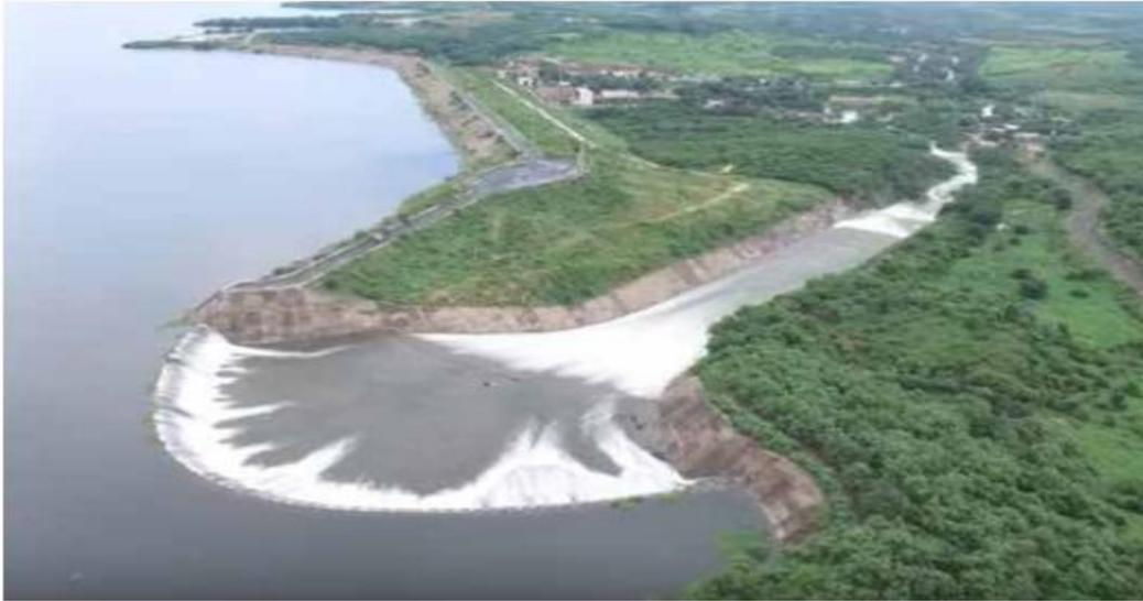
**Figura 1.3.** Vista aérea de un aliviadero de abanico de la presa Sanalona, México.
