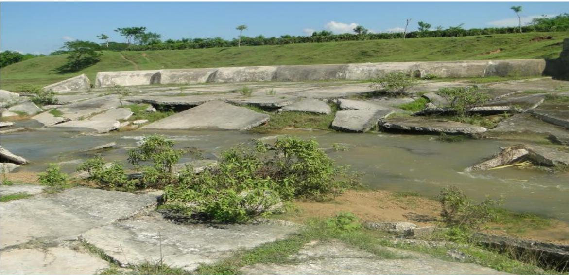
**Figura 2.3** Imagen del aliviadero de la presa Joturo en mal estado. **Fuente propia.**
