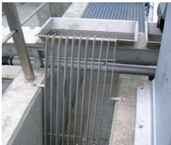
**Figura 1.4 Cámara de rejas de limpieza manual**
