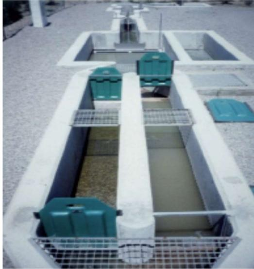
**Figura 1.5 Desarenador rectangular de flujo horizontal de doble canal**
