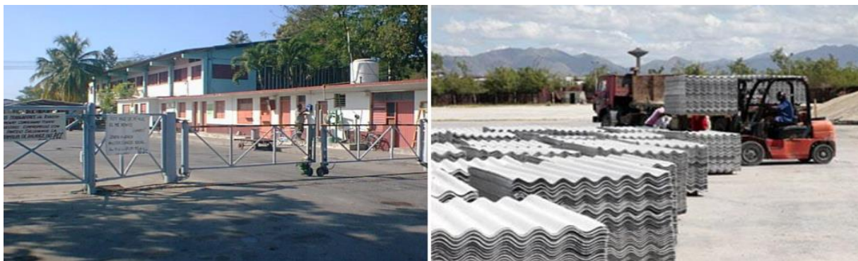
Figura 3.4. Foto de la fábrica de Asbesto-Cemento Armando Mestre. Fuente: (Valdés et al. , 2014a).
