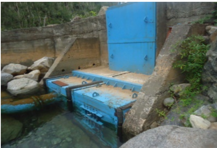
Figura. # 2.1 a. Obra de toma.
