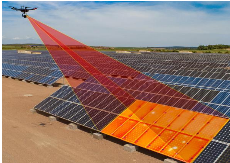
Figura 59. Inspección de granja solar aplicando guiado GPS
