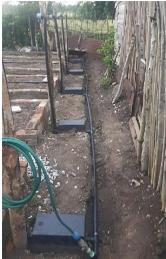
Figura 10. Instalación de las electroválvulas de los canteros
