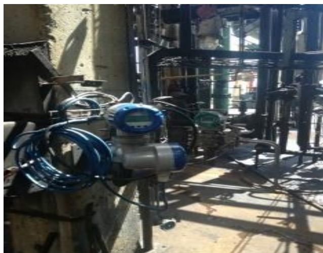
Figura 11. Filtro regulador de aire de la planta.
