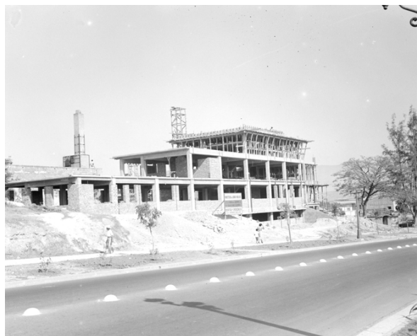
Hospital de emergencias, Santiago de Cuba 1951.
