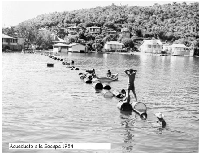
Acueducto a la Socapa, Santiago de Cuba 1954
