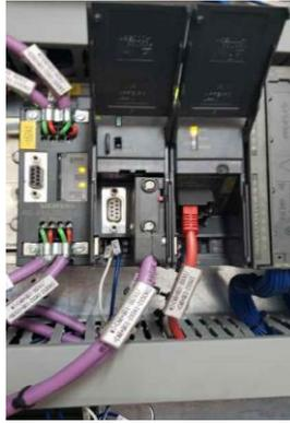
Figura 37. Repetidor RS 485 conectado al PLC.
