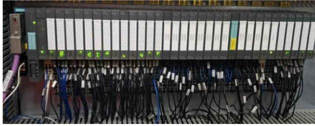
Figura 39. Módulos E/S conectados al PLC.
