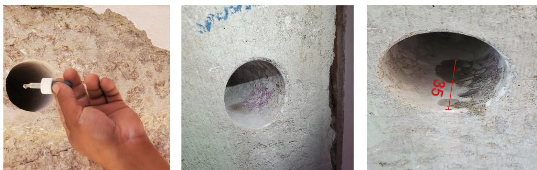
Figura.2.16. Ensayo de carbonatación.
