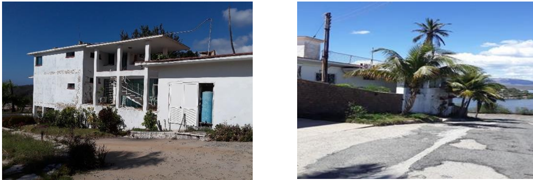
Figura 1.12. Véase la adaptación a la topografía.
