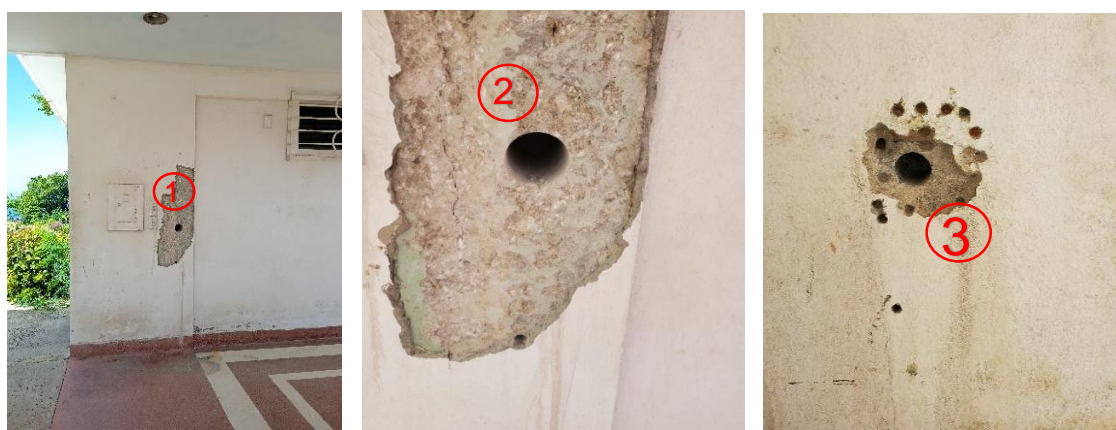
Figura 2.13. Muestras extraídas por la ENIA con la máquina extractora de testigo.
