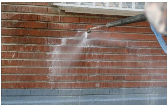
Fig.42 Chorro de agua a presión para retirar las manchas.
