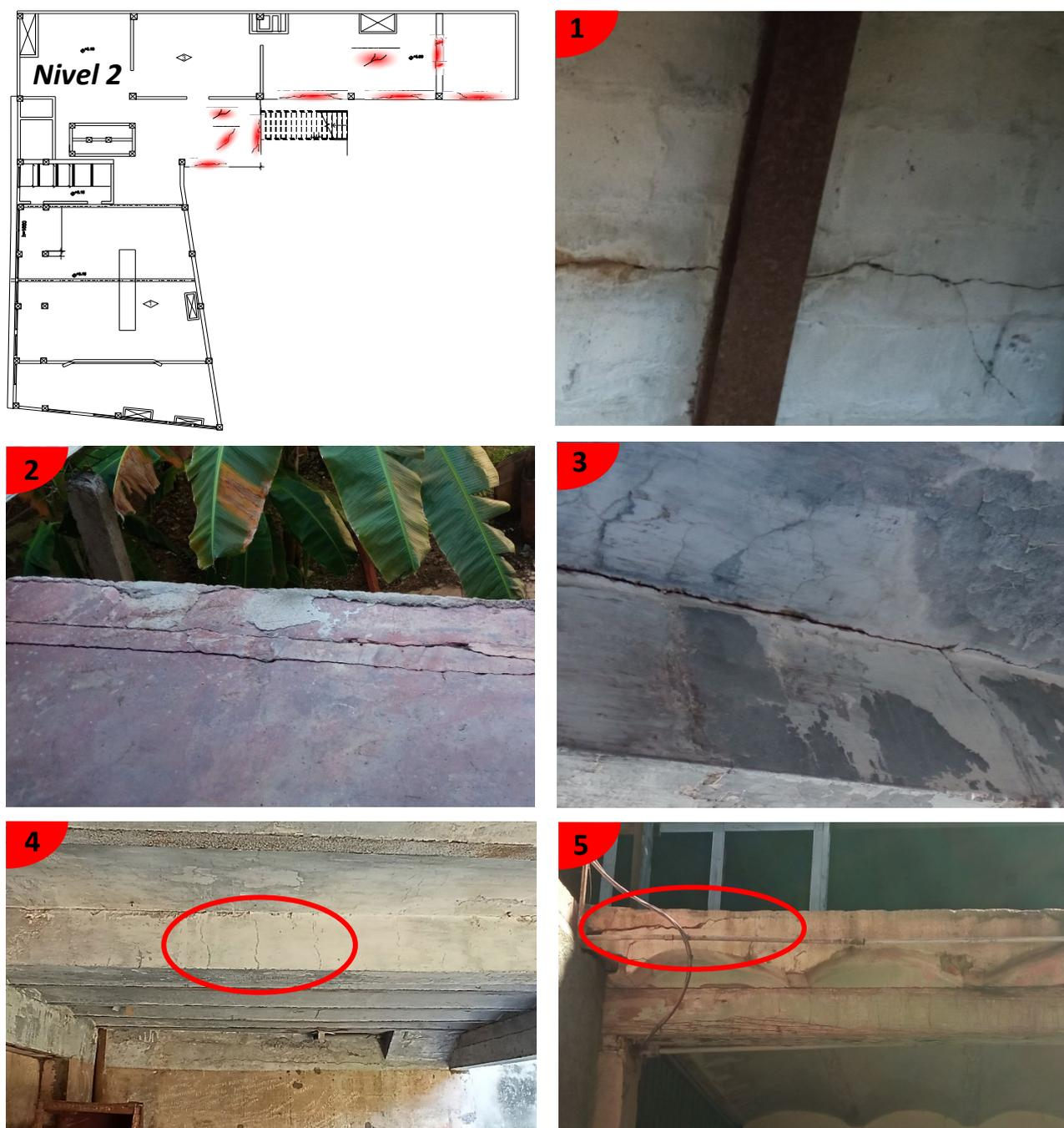
Fig.17: Levantamiento de grietas y fisuras
