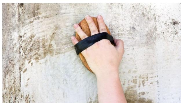
Fig.39 Cepillado con solución de agua jabonosa, para retirar suciedad de las paredes.
