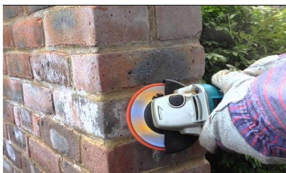
Fig.38 Amolado de paredes con discos de lijas finas.
