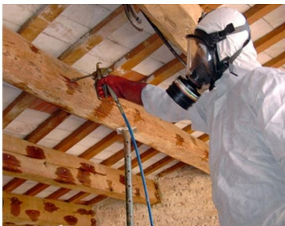
Fig.40 Aplicación de productos orgánicos mediante inyección
