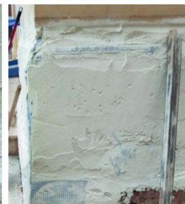
Fig.35 Ejemplo de un mortero de restauración aplicado en un muro exterior
