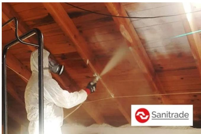
Fig.41 Aplicación de tratamientos fungicidas mediante fumigación
