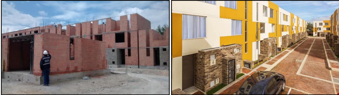
Figura 5: Construcción con mampostería estructural de Andria Casas. Figura 6: Fachadas principales de las viviendas. Fuente: Alfonso, H. (2016).
