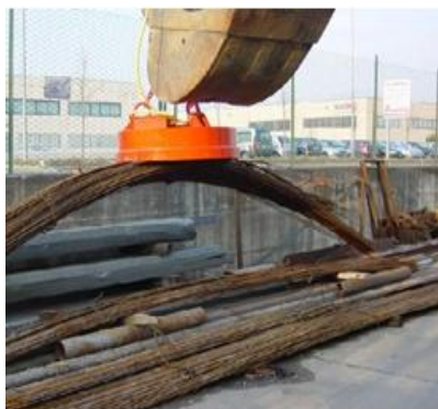
Levantamiento de cargas de acero.
