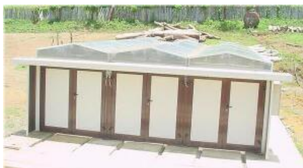
Figura 1.8. Secador solar para madera SecSol, Pinar del Río.
