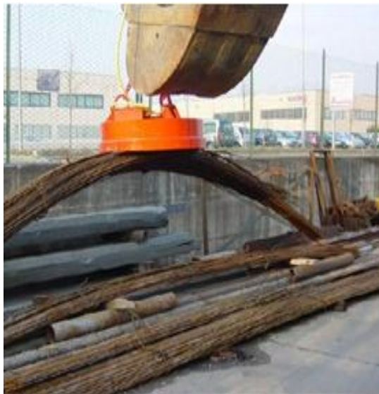
Levantamiento de cargas de acero.
