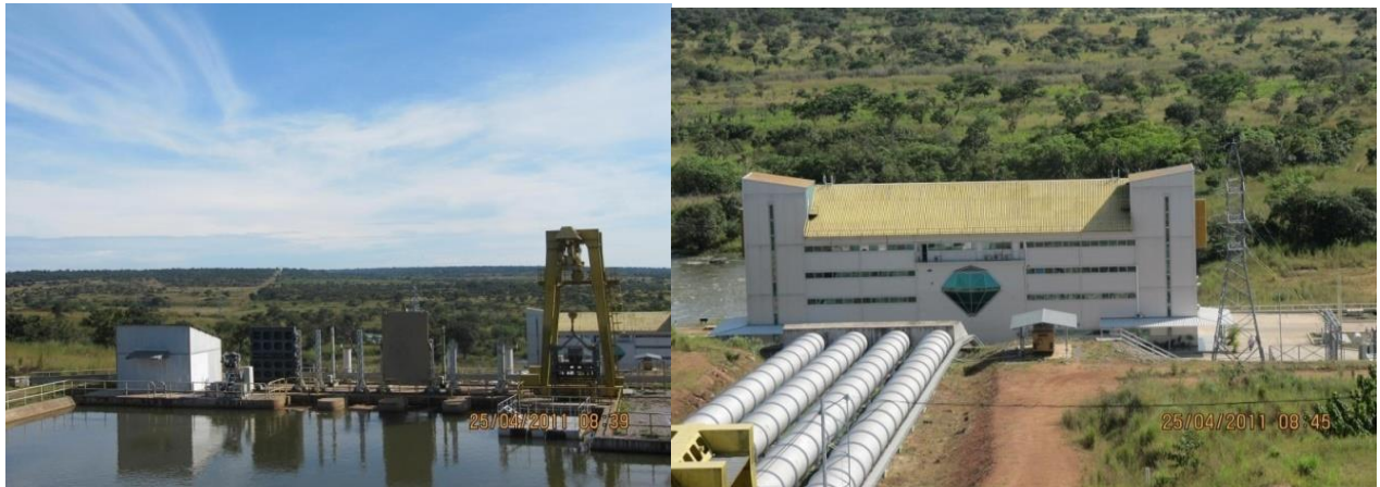
Figura 1.2.b. Vista exterior de la toma de agua, tubería reforzada y edificio de la central Hidroeléctrica Chicapa en Lunda Sul-Angola.
