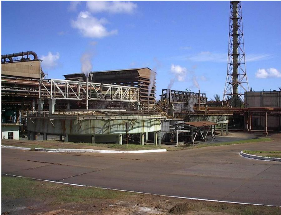
Imagen B.2. Sedimentadores de pulpa de carbonato donde fueron tomadas las muestras de licor residual para los ensayos de bioadsorción.
